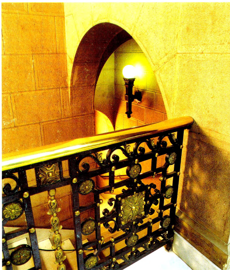
Escalera de acceso al tercer piso.
