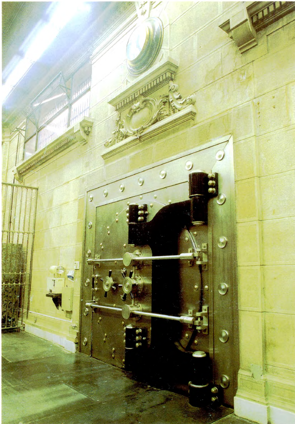
Bóveda de Tesorería.
