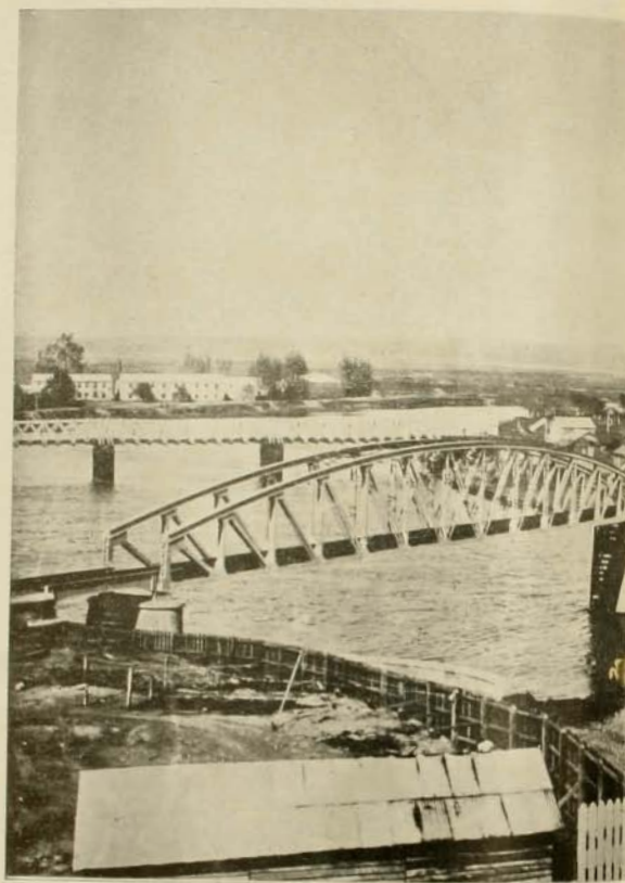
Puente sobre el río Colc
